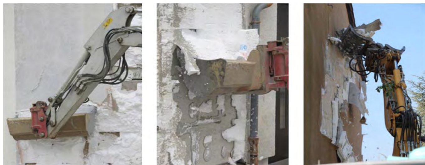
Demolizione di sistema a cappotto esistente
