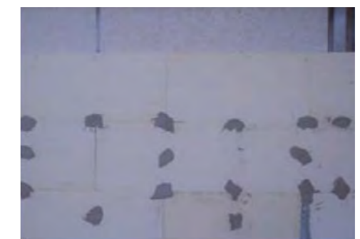
Esempio di tasselli incassati non a filo e giunti con colla rasante impiegata a copertura
